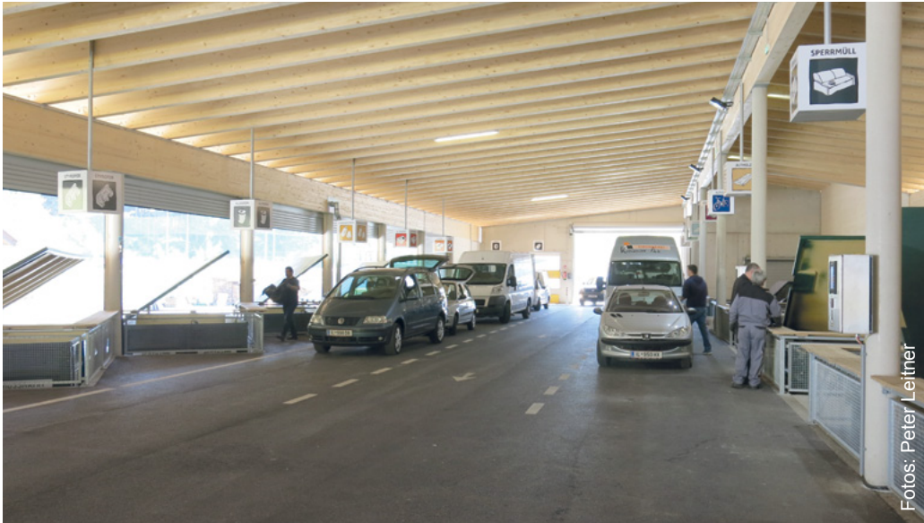
Die Dachträgerkonstruktion im Recyclinghof wurde von der Imster Firma HTB installiert.
